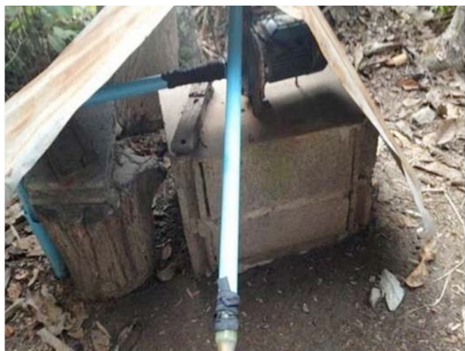
ภาพที่ 1 ลักษณะบ่อน้ำบาดาลปัจจุบัน
